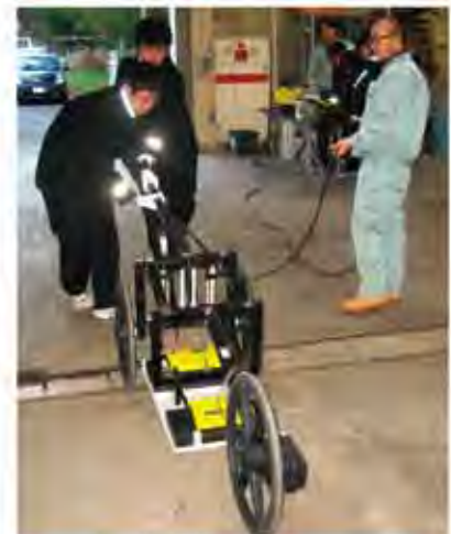
地下レーダーで探索中
